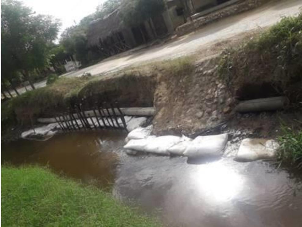
Foto 1. Obra temporal existente, tubería lastrada
